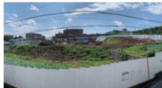
マンション工事現場
