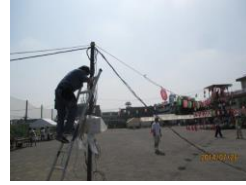
③電気配線作業
